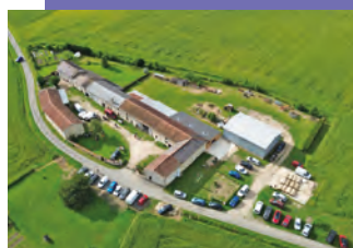
Boulangerie artisanale et vente de produits locaux à la ferme de Chantemerle (Vézières) : 50 000 €
