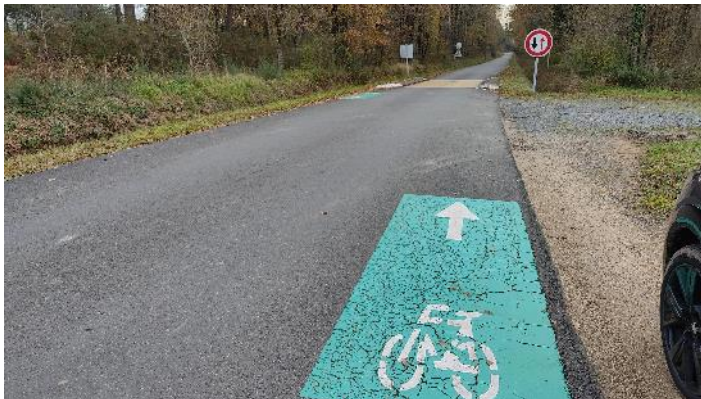
Les marquages au sol de la D49 entre Central Parc et les Trois-Moutiers – Iter 2023
