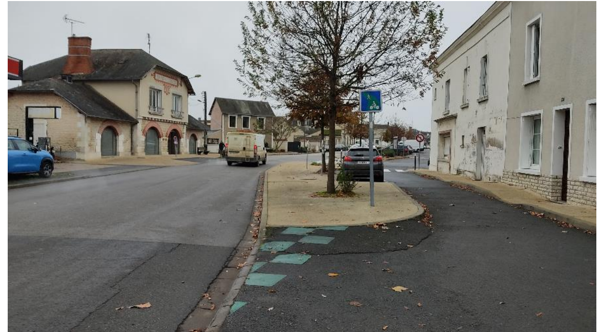
La voie verte sur trottoir du boulevard Jean Pascaud sur la commune de Loudun – Iter 2023
