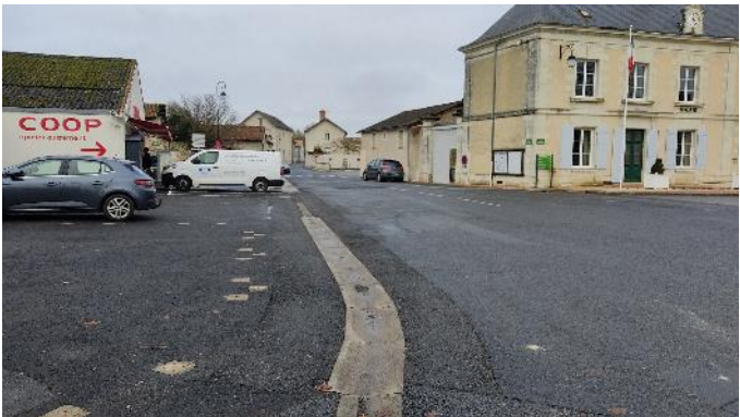
Intersection principale de Saint-Jean-de-Sauves
