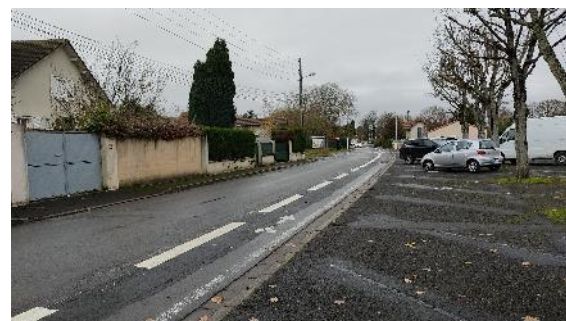
Double sens matérialisé sur la commune de Loudun – Iter 2023
