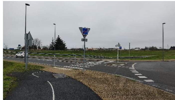
Des traversées cyclables non gérées par la piste cyclable de la zone d'activités des Landes – Loudun – Iter 2023
