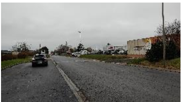
Emprise viaire des voies de la zone des Aubuies
