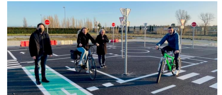
Piste d'apprentissage du vélo, à Bram (11) Source : Ville de Bram
