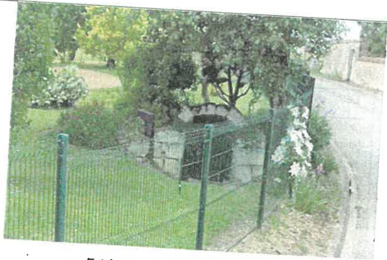
Entrée de cave voûtée en pierre de tuffe
