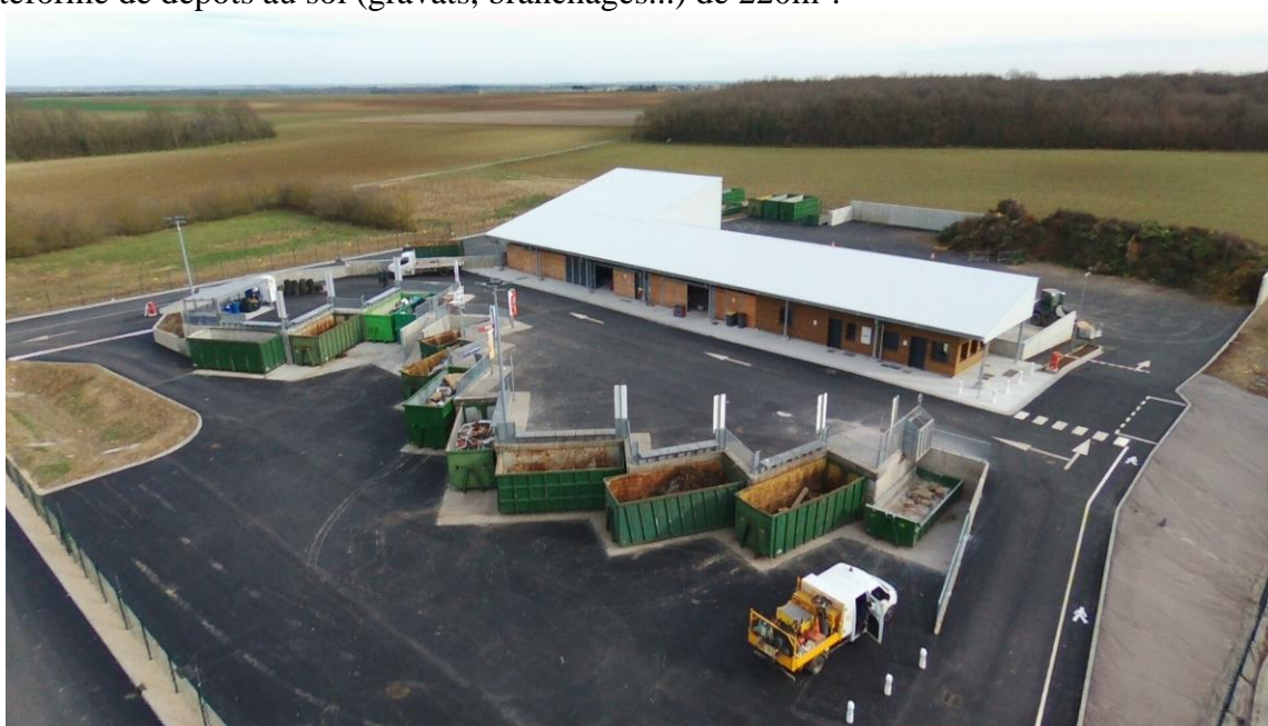
Déchèterie de Loudun-Messemé
