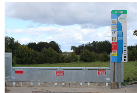
Mise en place de garde-corps
